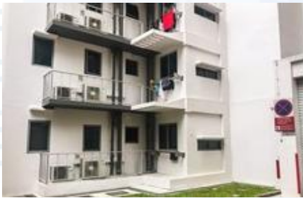
Sàn cực nóng máy lạnh an toàn và dễ tiếp cận để bảo trì
