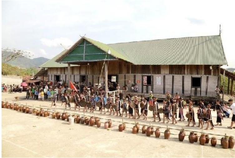
Những ngôi nhà rông làm mới, vì nguyên liệu gỗ, tranh khan hiếm nên những năm gần đây, ngôi nhà rông được lợp mái tôn, khung sắt
