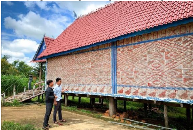
Tường của nhà rông được đan thủ công từ tre, nứa
